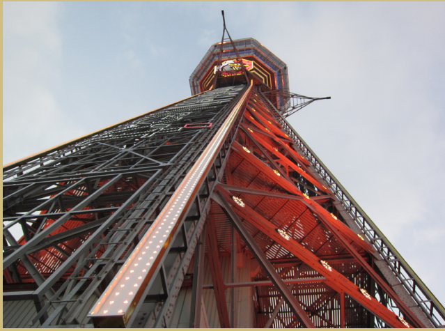
ライン状照明はLEDモジュールが2列に設置されている。
